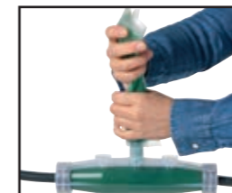
Positionner le bec verseur sur le moule, faire un quart de tour pour libérer la résine et remplir la trousse
